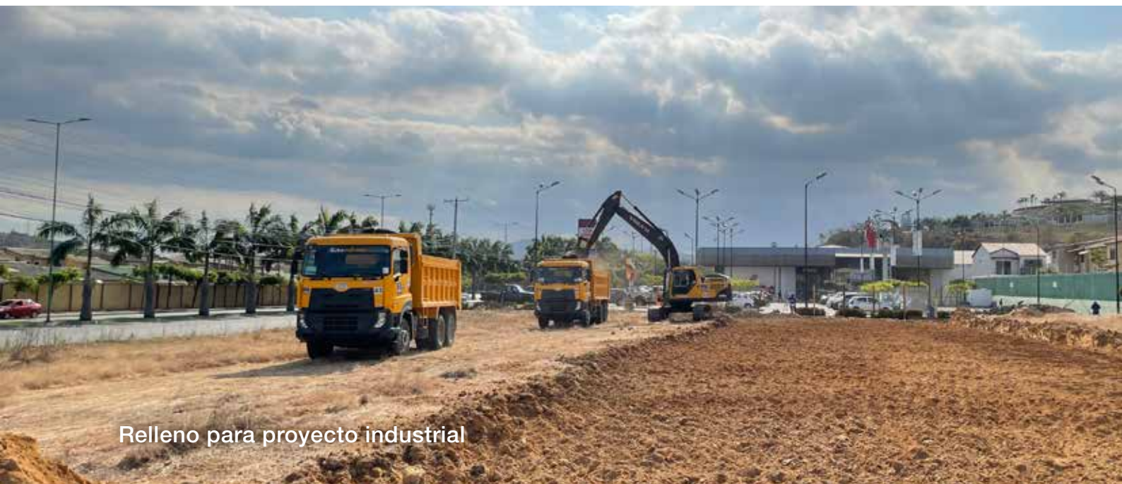
Movimiento de tierras para proyecto habitacional
